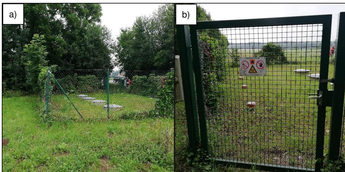
**Abbildung 4: Flüssiggaslager: a) Domdeckel, Blickrichtung Norden b) Lüftungsöffnungen im Bereich des vorhandenen Erdwalls (links im Bild), Blickrichtung Süden.**
