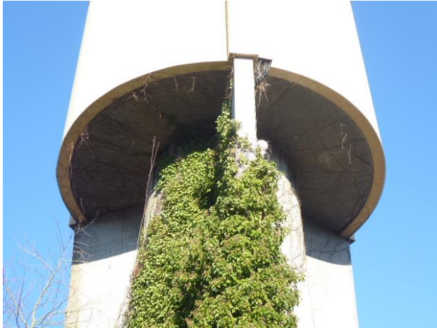
Abb. 3: Unterseite des ehemaligen Wasserspeichers mit Turmfalkenhorst auf Stromleitungen mit Blick aus südwestlicher Richtung.
