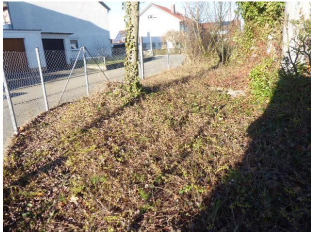
Abb. 9: Spärlicher Grasaufwuchs im Umfeld des Wasserturms auf verdichtetem Boden ohne Hohlräume.
