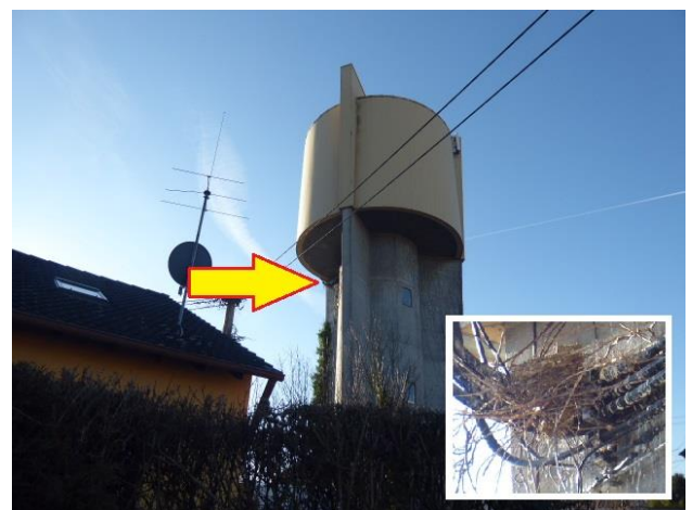
Abb. 2: Unterseite des ehemaligen Wasserspeichers mit Turmfalkenhorst auf Stromleitungen mit Blick aus nordöstlicher Richtung.
