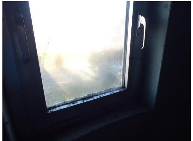
Abb. 6: Verschlossene Fenster ohne Beschädigungen verhindert den Zugang quartiersuchender Tierarten.
