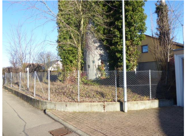
Abb. 4: Blick auf die Südwestseite des ehemaligen Wasserturms mit dichtem, mehrere Meter hohem Efeubewuchs.
